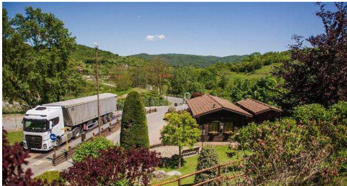
Traitement de Déchets non Dangereux – La Filippa (Italie)
