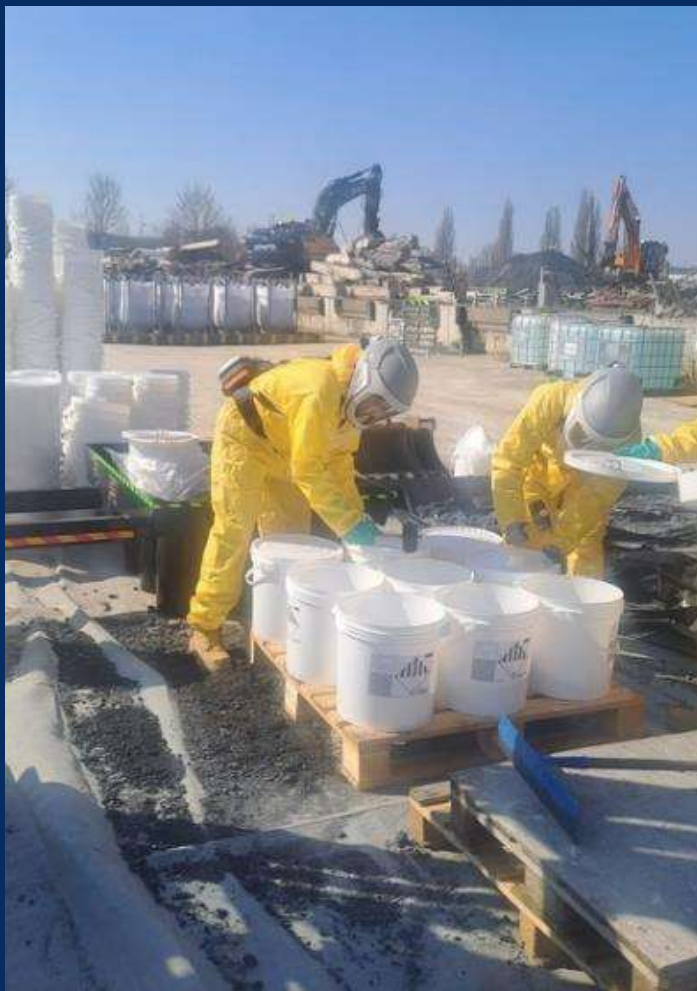
Intervention d'urgence à Rouen - SUI (France)
