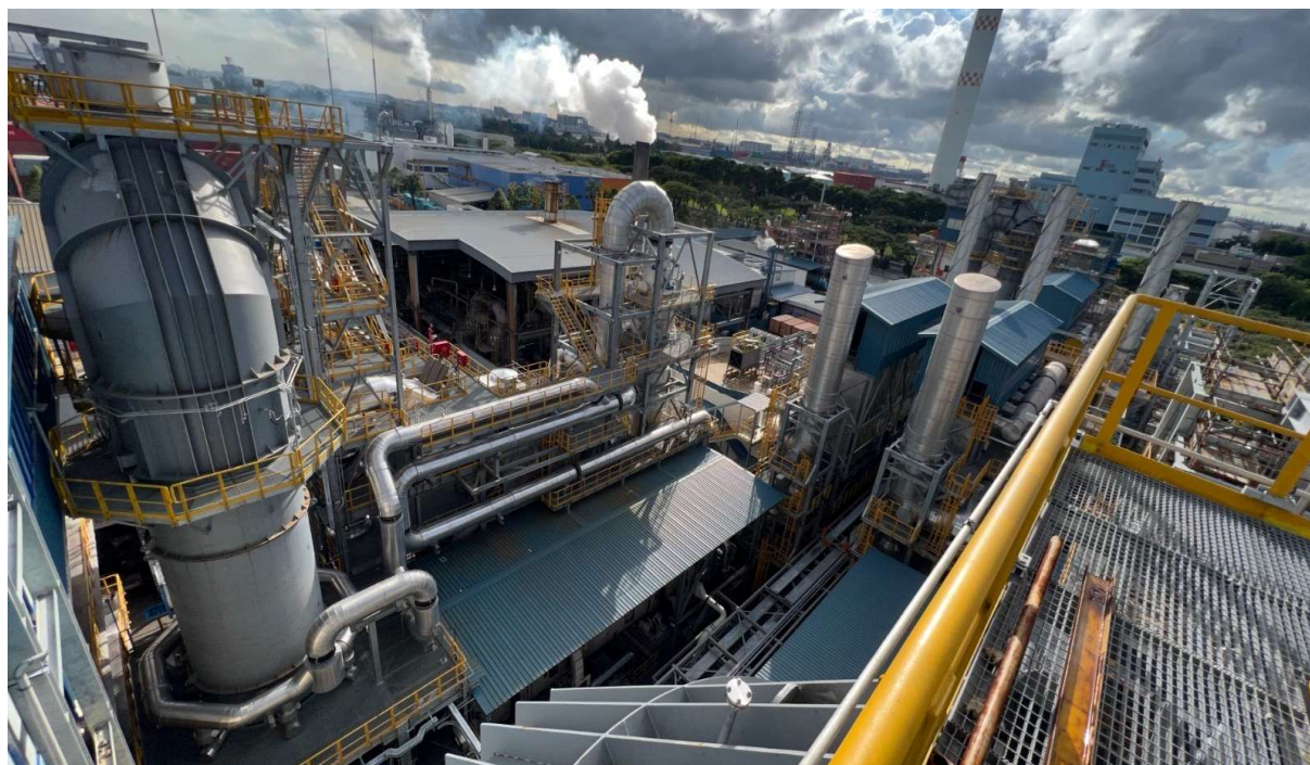
Traitement de Déchets Dangereux - Eco (Singapour)
