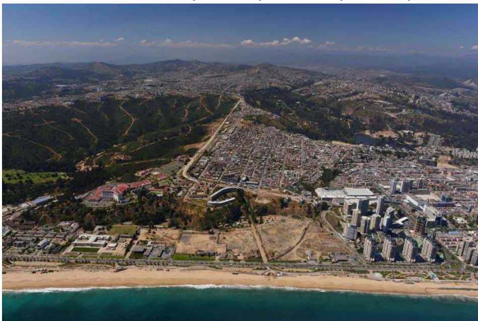
Viña Del Mar (Chili) Une friche de 7 ha polluée aux hydrocarbures Un chantier emblématique d'une durée de 3 ans
