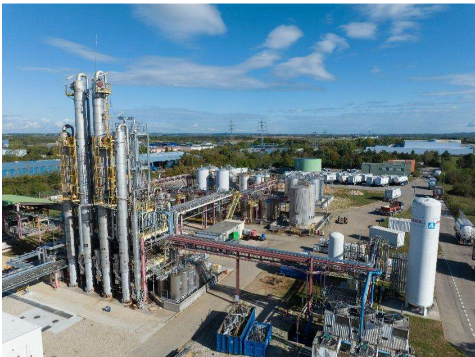
Régénération de solvants et purification chimique (Speichim Processing – France)
