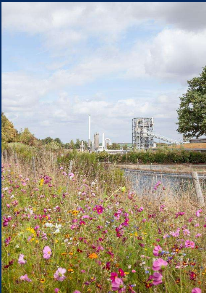
Valorisation des combustibles solides de récupération - Changé (France)
