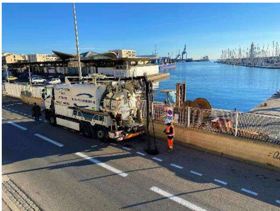
Sécché Assainissement Sécché Assainissement 34 Sécché ARI
