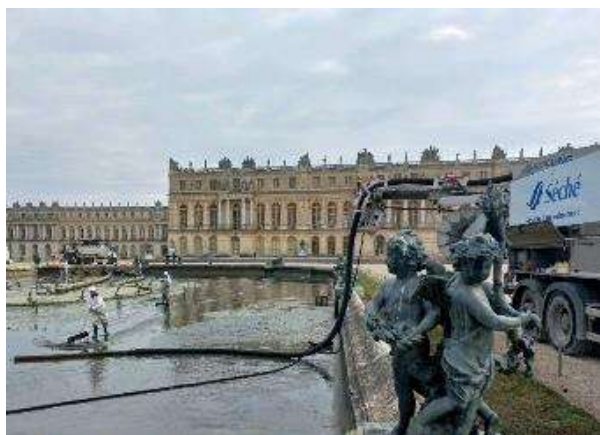
Sécché Assainissement Sécché Assainissement 34 Sécché ARI
