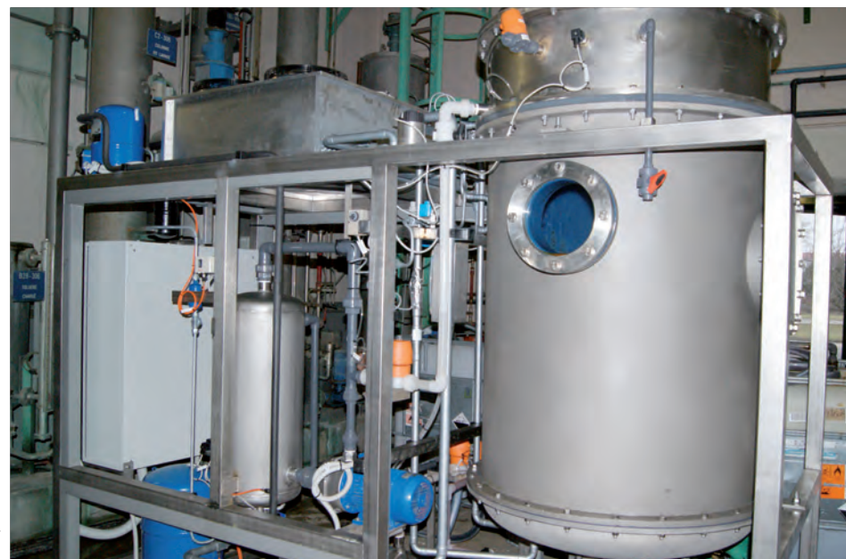
Evapo-concentrateur pour bains chromiques
