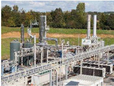
SES : valorisation énergétique de déchets non dangereux
