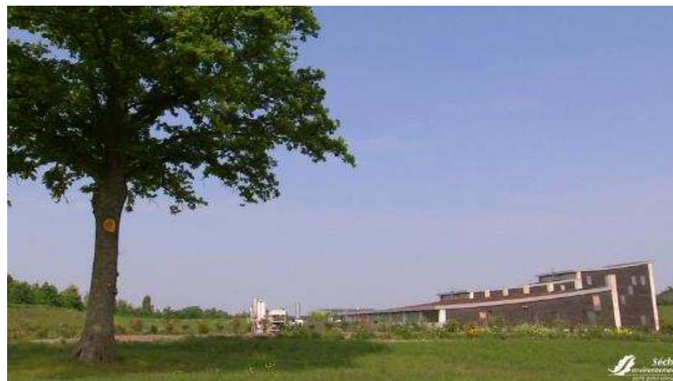
Changé site – SRF energy recovery
