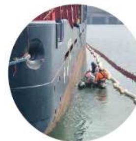
Chantier de dépollution Charente-Maritime (17)
