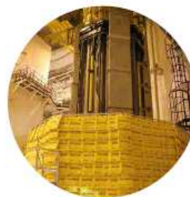
Mise en place de radio-protections (France)
