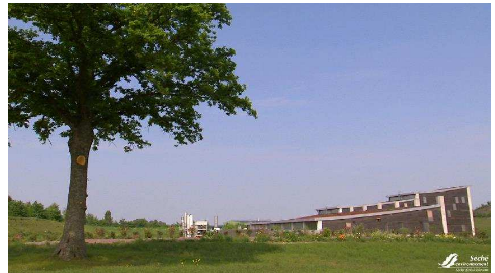
Changé site – SRF energy recovery
