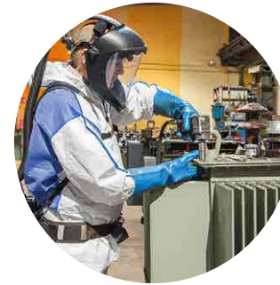
Décontamination PCB Saint Vulbas (01)
