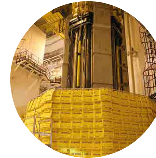
Mise en place de radio-protections (France)
