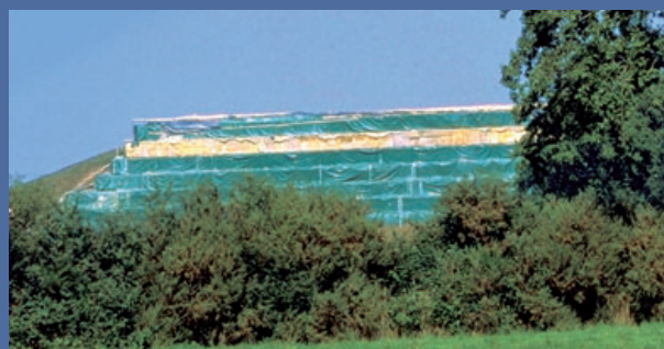
Alvéole de stockage site de Changé
