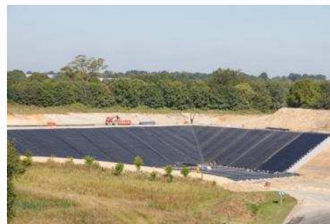
Alvéole de stockage
