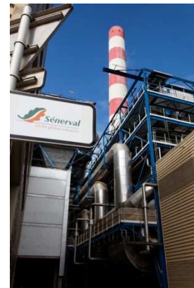
Extension d'un réseau de chaleur à Strasbourg-Sénerval
